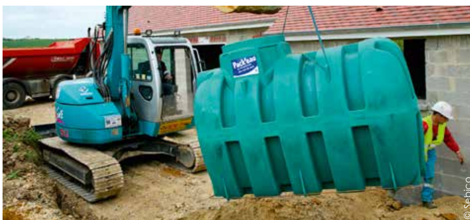
Voici une cuve de 3 000 L prête à être installée dans une fosse calibrée, avant d'être maintenue par une épaisseur latérale de 20 à 30 cm de remblai.
